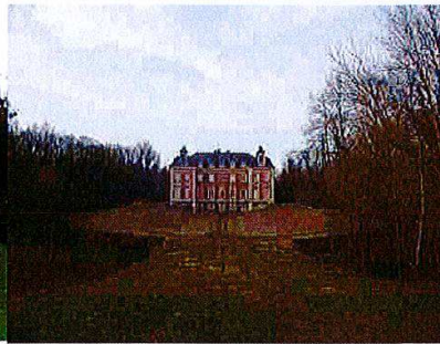
La façade sud (vue lointaine)
