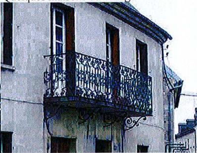
Un balcon avec ferronneries (détail)
