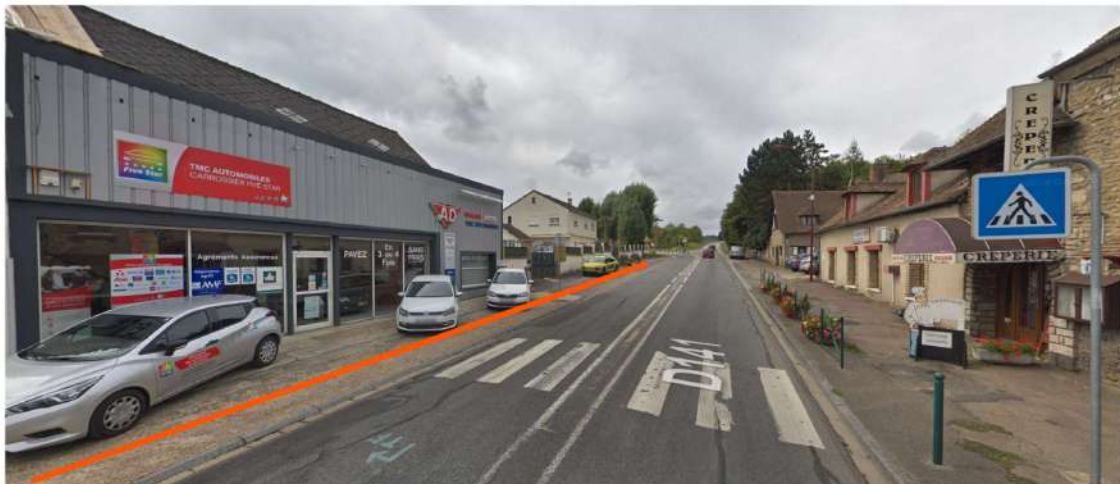
Pacy sur Eure, rue Charles Ledoux Réalisation trottoirs et stationnement - côté impair (section rue Pierrefeu vers Evreux)
